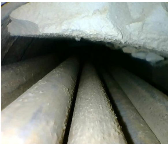
Fig.1 - Stato di conservazione dei cavi post-tesi in condotti non intasati. Rilievo effettuato su alcune strutture della metà degli anni '70. / Surface condition of post-tensioned wires in ungrouted ducts. Observations carried out on structures built in the half of the '70s.
