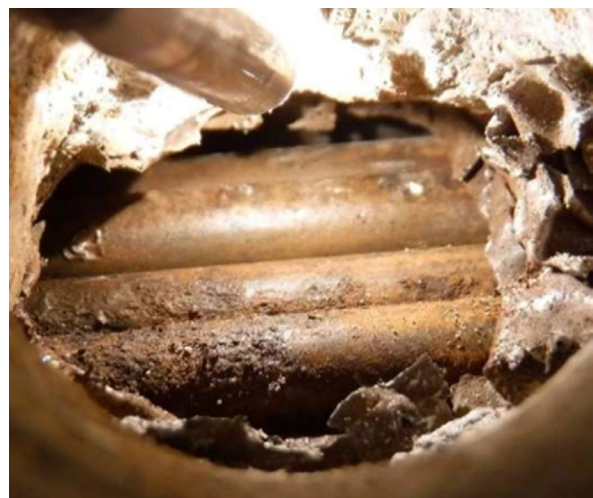
Fig.1 - Stato di conservazione dei cavi post-tesi in condotti non intasati. Rilievo effettuato su alcune strutture della metà degli anni '70. / Surface condition of post-tensioned wires in ungrouted ducts. Observations carried out on structures built in the half of the '70s.
