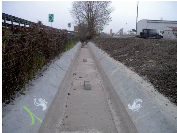
Fig. 2 - Vista del fosso di guardia - View of the culvert
