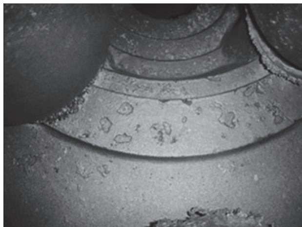
Fig.17 - Difetti di colata provocati dai manicotti in fibra
